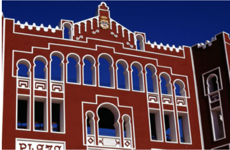
FACHADA PRINCIPAL DE LA PLAZA DE TOROS
