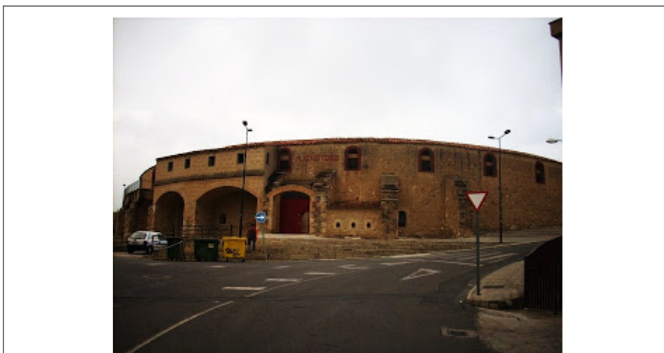
Plaza de toros de Plasencia, foto Panoramio
