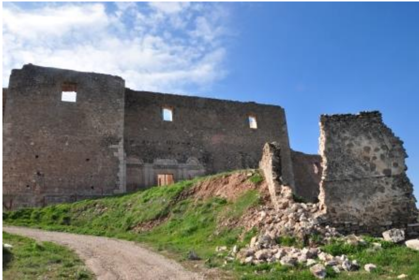
Construcciones en el interior del recinto
