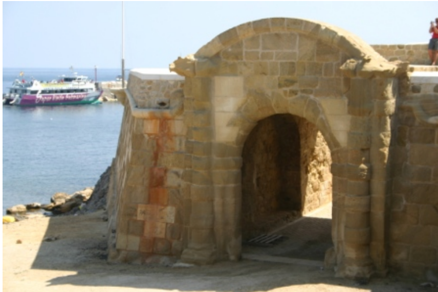
PUERTA DE ACCESO AL MUELLE
