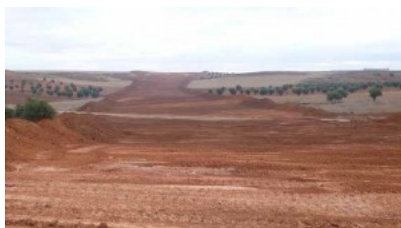
DESBROCE PREVIO A LA CONSTRUCCIÓN DE UNA AUTOVIA
