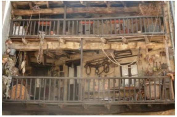
DETALLE FACHADA CASA
