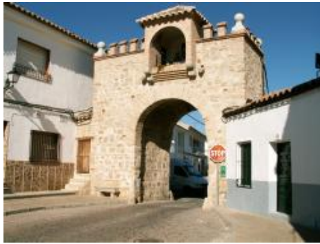
PUERTA DE BELEN- RESTOS DE LA ANTIGUA MURALLA
