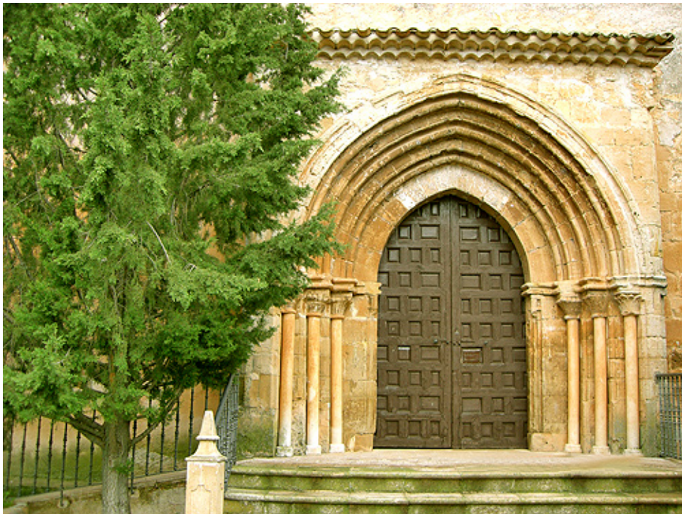
Pórtico ermita de Ribatajada
