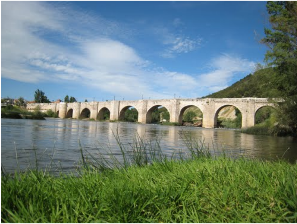
Puente mediaval sobre el Pisuerga, en Cabezón de Pisuerga
