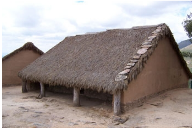
Reconstrucción de una vivienda
