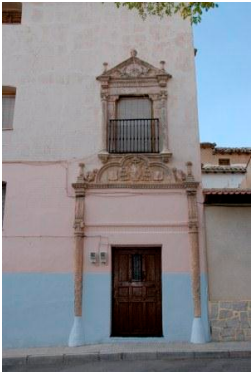
Fachada de la casa del Cardenal Loaysa. Foto Rubiales.
